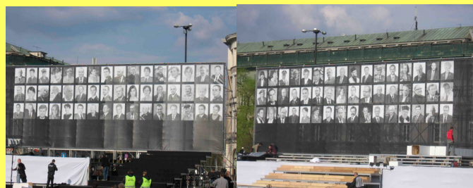
Budowa ołtarza na Pl. Piłsudskiego
